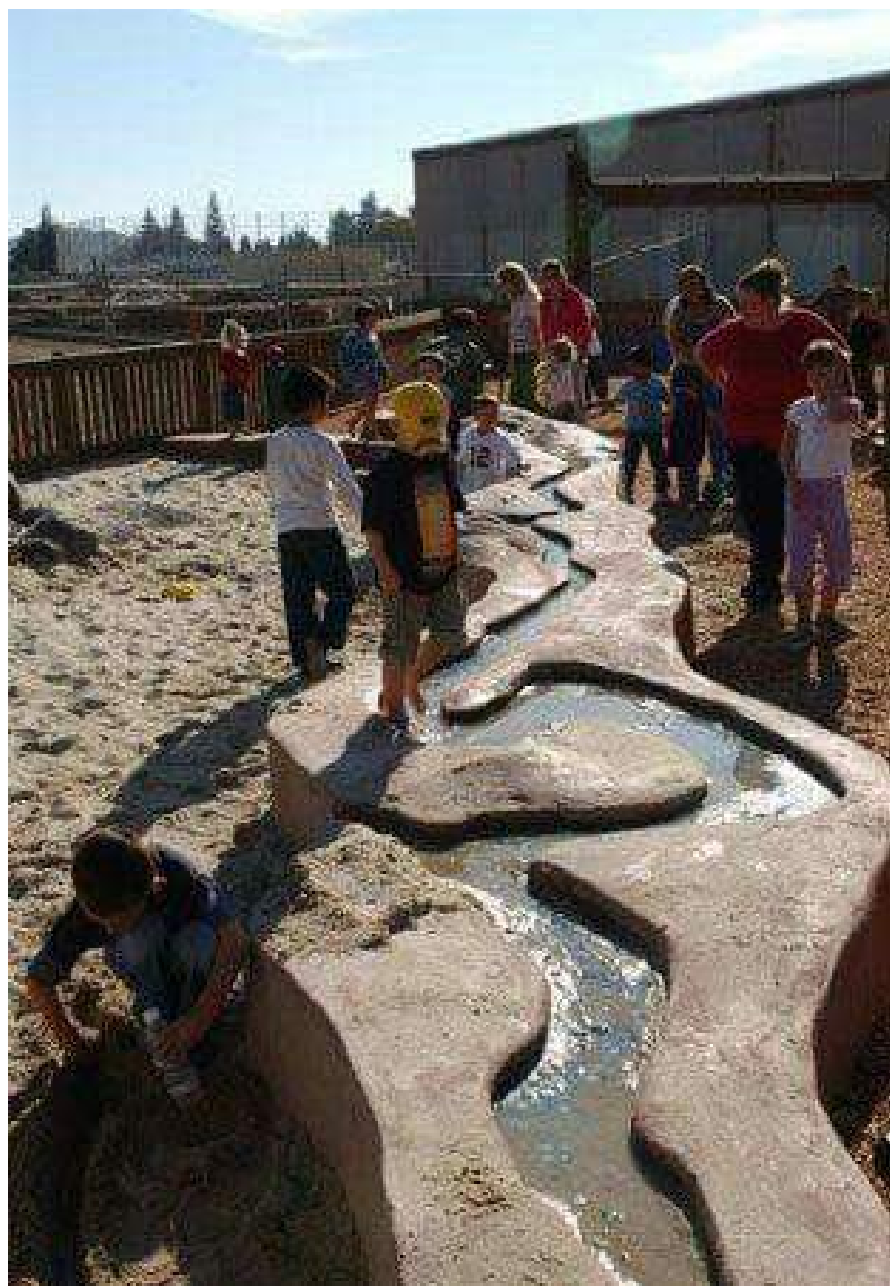
Zdj. nr 17. Przykładowy ciek wodny w kształtowanym betonie
