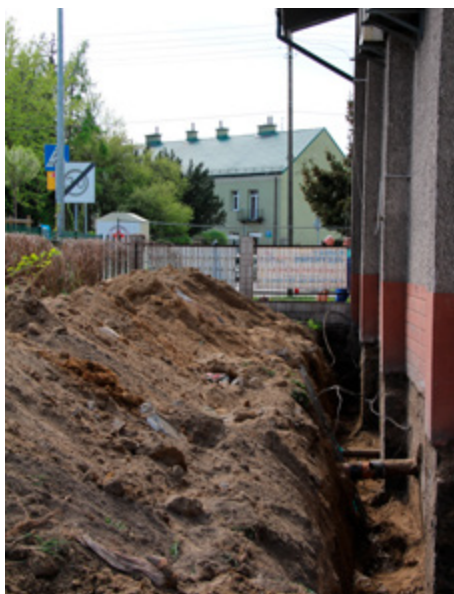
Fot. W GCKiS w Jabłonie prace już trwają
