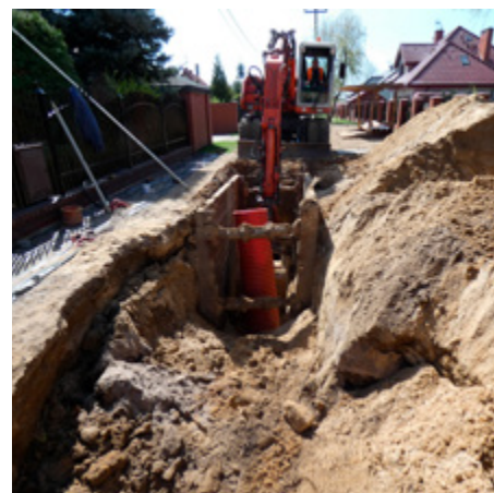
Fot. Kanalizacja ul. Kwiatowa
